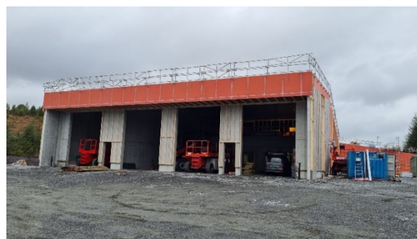
Skogsskiftet stasjon vert i søre enden av Servicebygg sør. Her ser ein opningane til brannbilgarasjane. Bilete ØBR KF.
