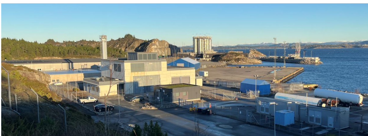
Figur 6-9: I front: MOWi sitt anlegg til venstre, Kogen-anlegget til Eviny i midten, delar av LNG-anlegget til høgre. Vi ser og Northern Lights sine tankar i bakgrunnen. Norconsult des 2024.
