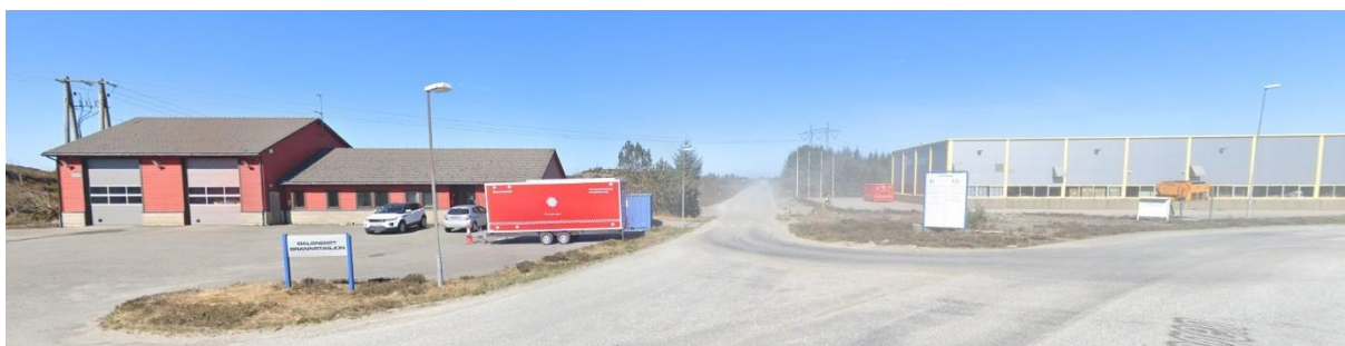
Figur 6-7; Brannstasjon og lagerbygg ved innkøyringa til området. Bygga er relativt låge. Frå googlemaps.
