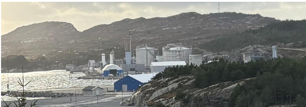
Figur 6-8: LNG- anlegget sett frå Ljøsøyna mot sørvest (Blomøynuten m/ mast i bakgrunnen). Relativt store tankar., Norconsult okt 2024
