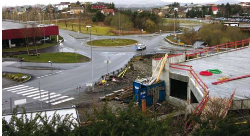
Området ved Stovevatnet sett frå krysset inn til Grønamyrsvegen. Foto: HJR
