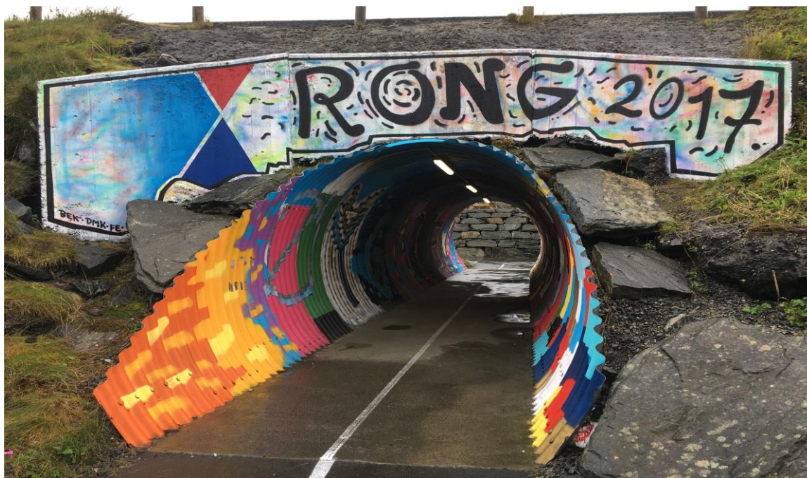
Figur 2 Fotgjengarundergang under fylkesveg 561 Rongøyveg- Rong sentrum
