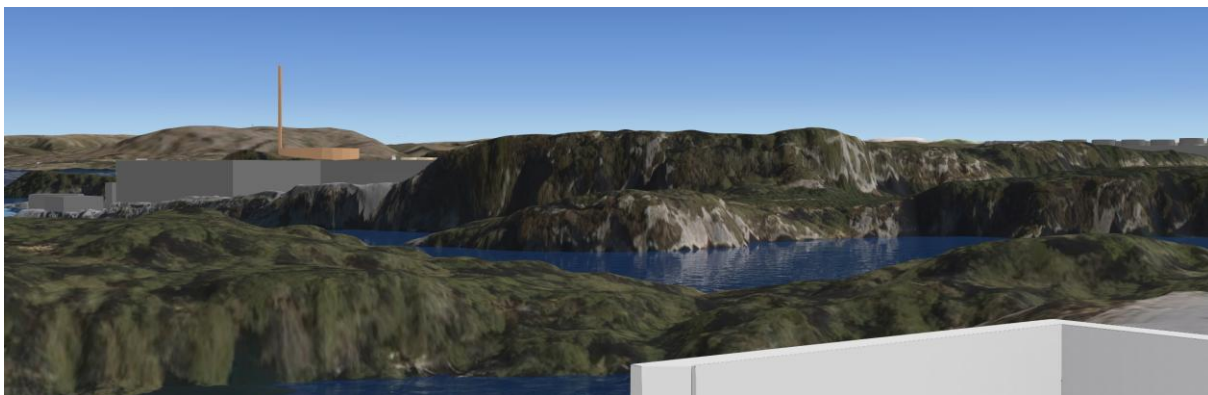
Figur 4: Frå balkong rekkehus Osundet 3A. Planforslag ved offentlig ettersyn
