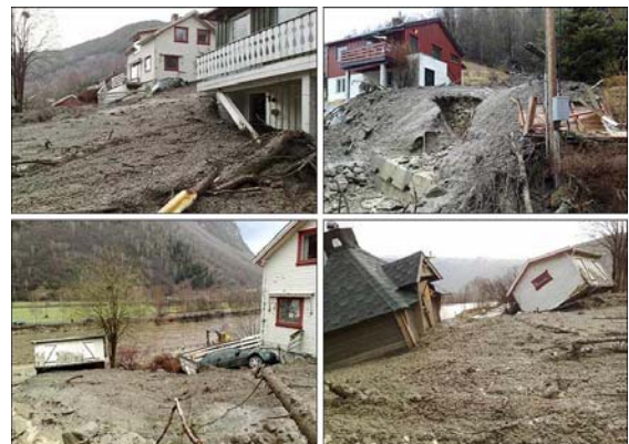
Figur 1.2: To hus ble totalskadet av jordmassene da raset gikk i Otta 2008. Foto: GEIR OLSEN
