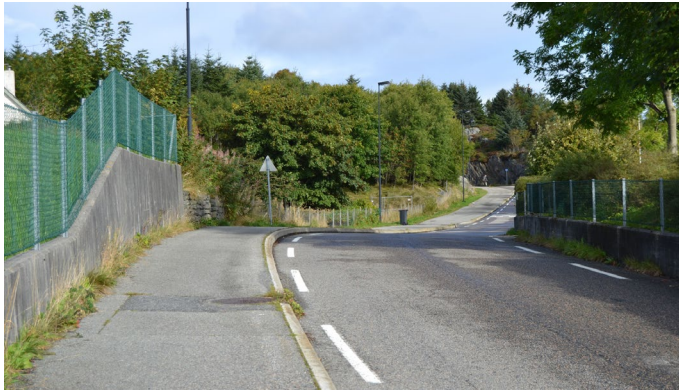
Kyrkjevegen med etablert fortau
