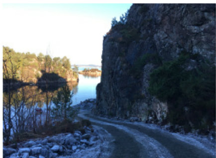
Skjering i fjellsida etter etablering av veg
