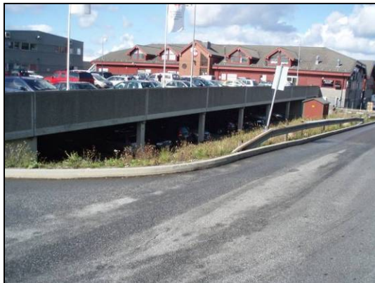
Figur 12.3.e: Dagens situasjon for tiltenkt plassering. Bildet viser det same som bildet over, men er tatt lenger sør i Grønmyrsvegen. Bildet er tatt mot nord.
