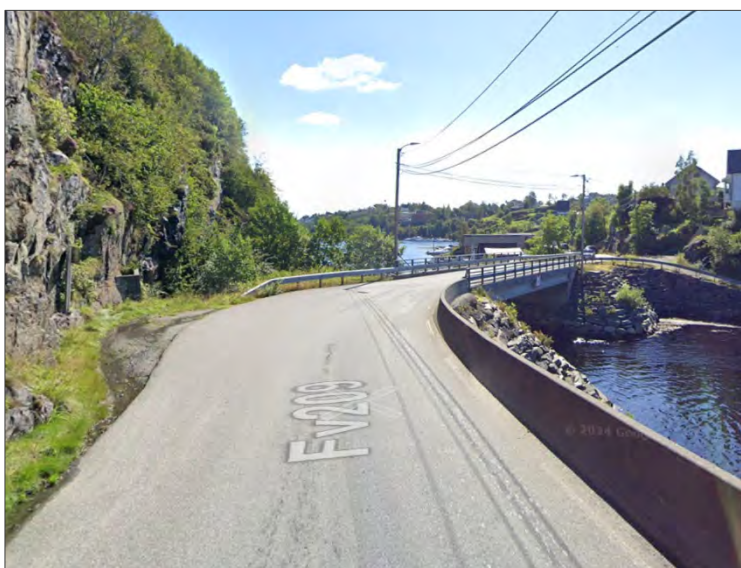
Figur 3-13: Arefjordvegen mot vest, ved Arefjord bru (Kjelde: Google Maps)
