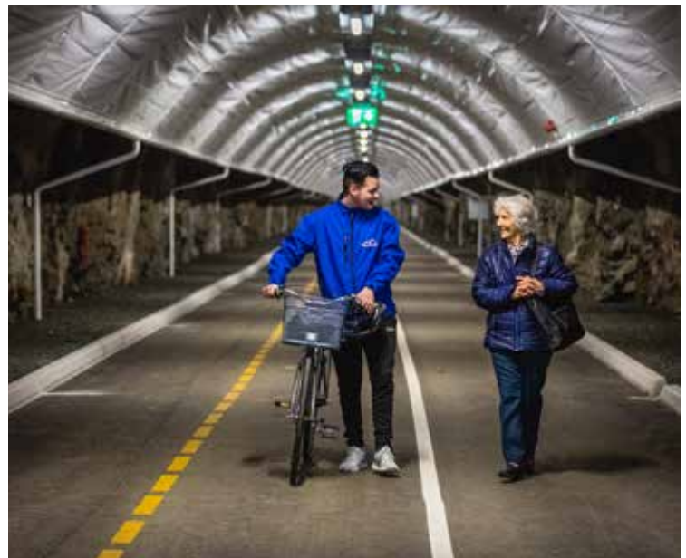
Gang- og sykkel tunnel i Kystbygarasjen, Fjell
