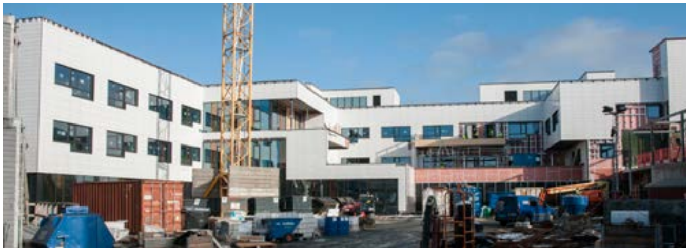
Lokalmedisinsk senter under bygging på Straume
