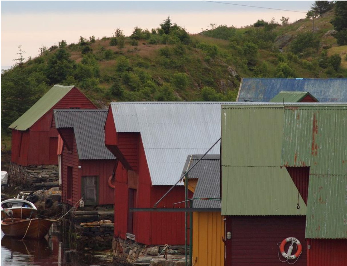
Figur 45 Lokal byggeskikk med naturlege fargar, bruk av stein og god kontakt med bakken. Herdlevær. Foto Halvor Skurtveit.
