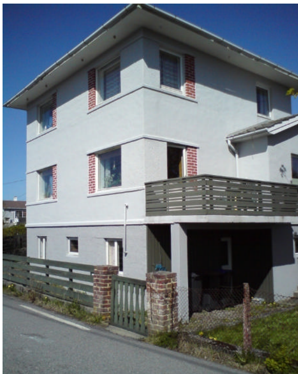
Bustad nær kai, som ein foreslår ombygga/ fjerna . Nedre etasje ligg ein halv meter lågare enn veg og kai. Her er risiko for stormflo.
